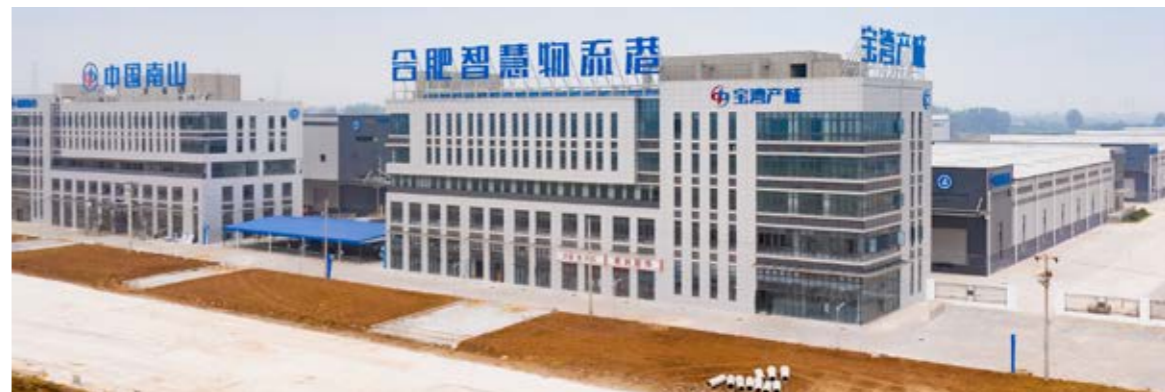
中国南山·合肥智慧物流港项目实景图
